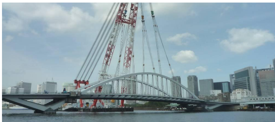
< 5月の架橋時の環状第2号線隅田川橋りょう（仮称） >
